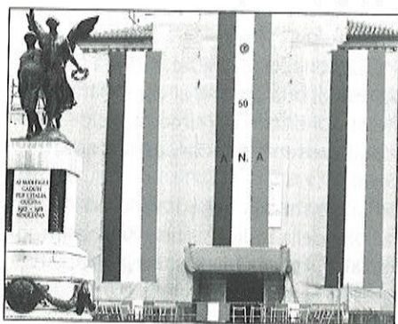
Una nota di Tricolore sulla facciata in restauro del Municipio.
